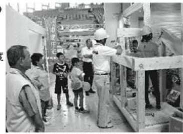
潮独自工法の木造住宅の組み立て実演に、来場者は足を止めて見入っていた
