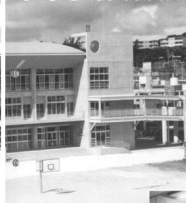
新築落成した与那原小体育館、左側の1階部分が幼稚園園舎
